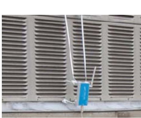
図-4 橋梁側アンテナ設置状況
